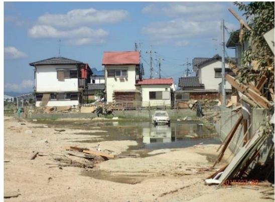
写真 38 : 末政川の決壊による大量の砂と湧き水
